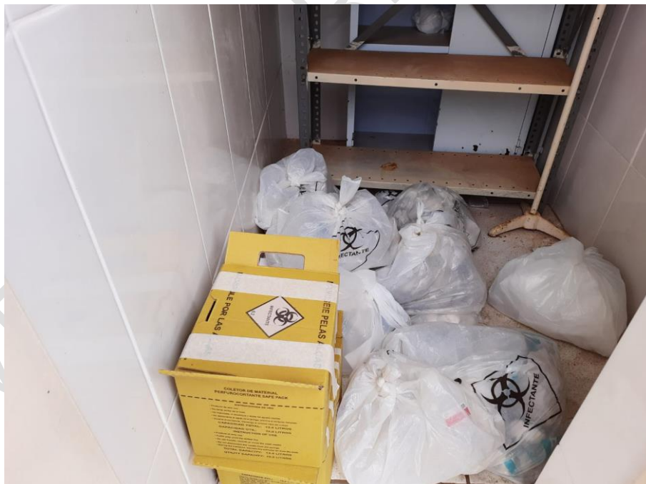
Figura 56: Local de armazenamento dos RSS na Unidade básica de Saúde Dr. José Rosseto.
