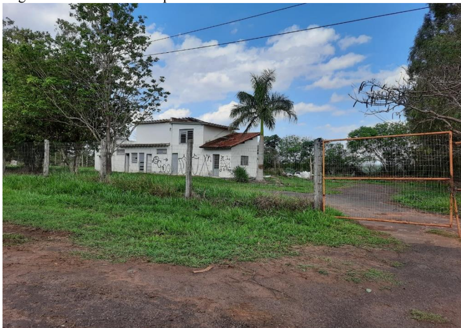
Figura 38: Local utilizado pelos catadores cadastrados.
