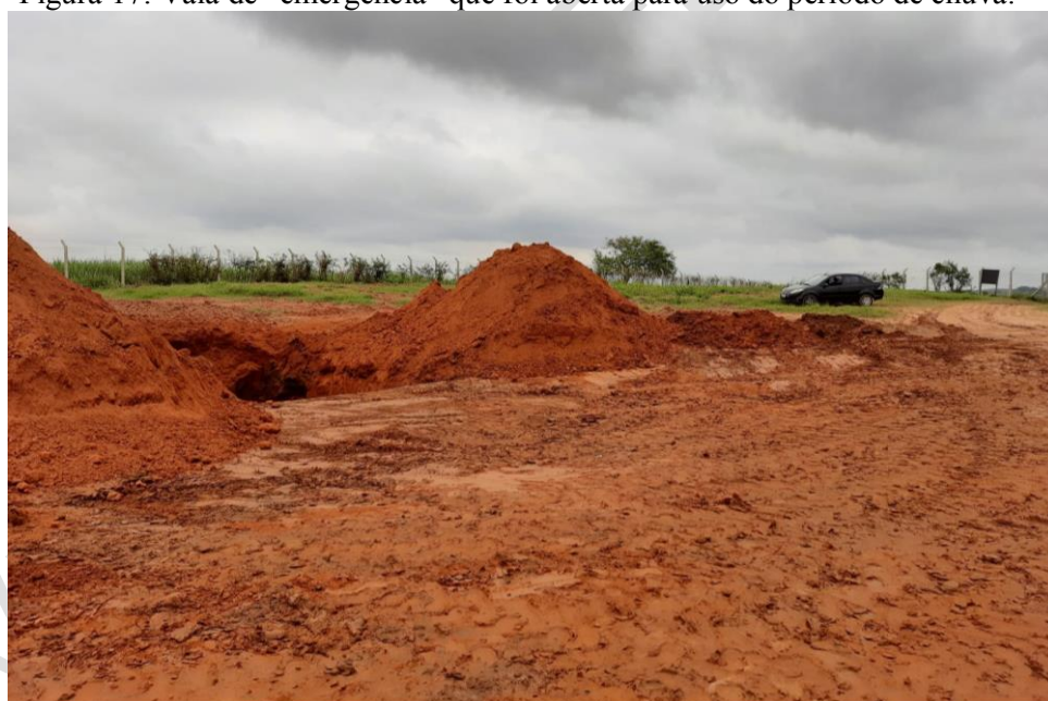
Figura 17: Vala de “emergência” que foi aberta para uso do período de chuva.
