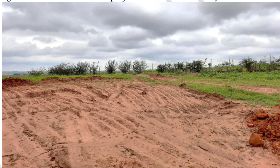
Figura 20: Vala do aterro municipal já encerrada sem identificação visual.
