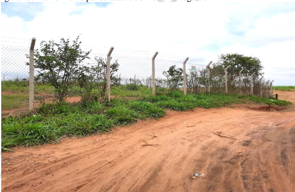
Figura 15: Aterro Municipal cercado e com cortina vegetal.
